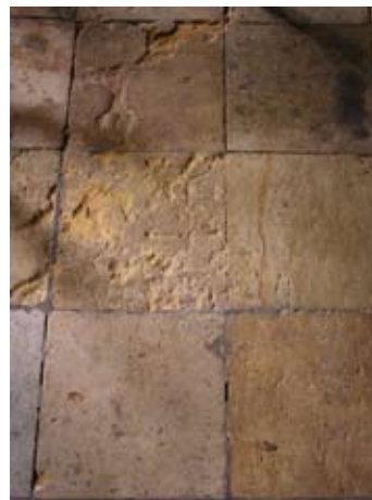
17.08.2005 Mit Heißdampf gereinigte, aber noch nicht weiter sanierte Bodenplatten im Mittelgang
