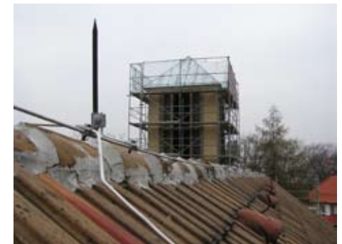
12.11.2004 Die Blitzschutzanlage ist aus Brandschutzgründen tlw. erneuert und die Vermörtelung der Dachdeckung ist - soweit erforderlich - ausgebessert worden
