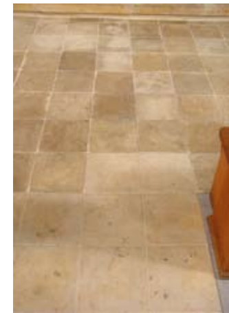
30.05.2006 Harmonie von ausgebesserten Sandsteinplatten im Altarvorraum und neuen Platten im Mittelgang
