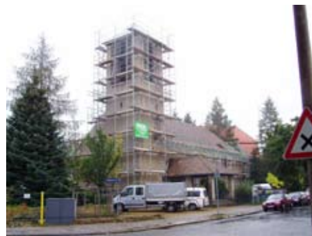
29.09.2004 Es ist mächtig Betrieb auf der Baustelle Bethlehemkirche
