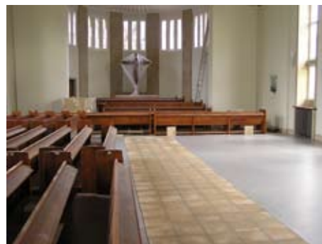
07.04.2006 Mittelgang mit neuen Sandsteinplatten, Linoleum im Kirchenbankbereich
