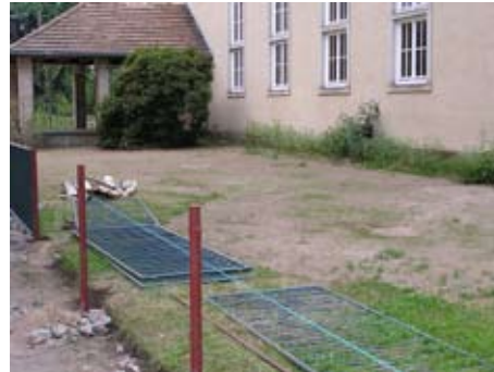
06.07.2006 Regenwasserversickerung ist fertig, erneuerte Zaunsäulen und alte Zaunfelder vor dem Anstrich
