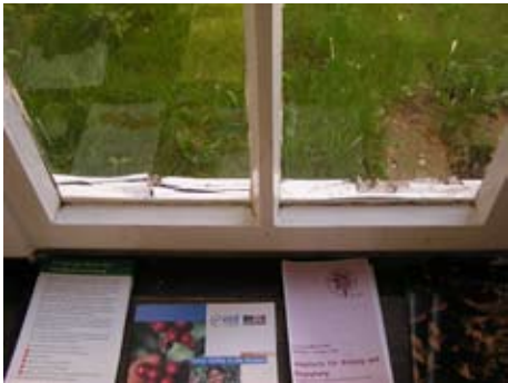
05.06.2005 Fenster im Kirchenvorraum im alten Zustand
