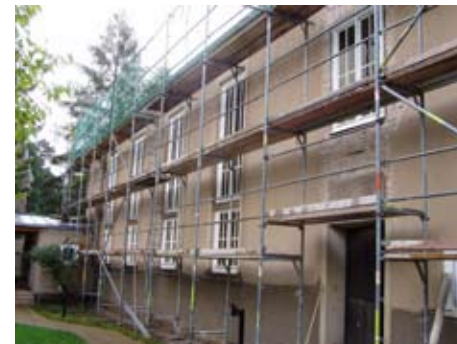
29.09.2004 Die Fassadensanierung ist im vollen Gange: oben abgeklopfter Putz, unten ist erste Schicht des Reparaturmörtels aufgetragen
