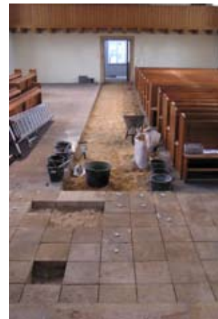
18.07.2006 Sanierungsarbeiten an der Treppe
