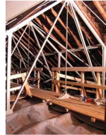
19.11.2004: Innendecke: Laufstege haben inzwischen Schutzgeländer erhalten, vom mittleren Laufsteg zweigen Wartungsstege zu den Dachfenstern ab, die Mineralwolldämmung ist mit Schutzfolie abgedeckt
