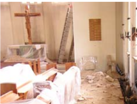
20.10.2004 Bodenaushub für Kabelgräben
