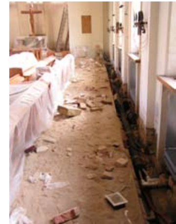
20.10.2004: Die Verlegung der Heizungszuleitungen schreitet voran, gleichzeitig werden Elektrokabel und Lautsprecherkabel im Kanal verlegt, die Travertinsockel sind in Eigenleistung entfernt worden
