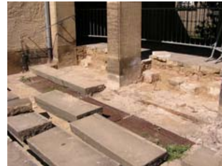
18.07.2006 Sanierungsarbeiten an der Treppe
