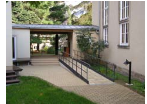
25.10.2006 Neue Rampe als barrierefreier Zugang zur Kirche und zum Gemeindehaus
