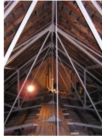
12.11.2004: Sanierung der Innendecke: Korrosionsschutz am Tragwerk erledigt, aus Holzdielen ist ein neuer Laufsteg entstanden, im Hintergrund wird Mineralwolle auf die Innendecke gelegt
