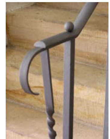
09.08.2005: Detail der gereinigten Sandsteintreppe zur Empore: Die schöne Steinfarbe und -struktur kommen wieder zur Geltung. Der eiserne Handlauf ist mit Eisenglimmerfarbe gestrichen.
