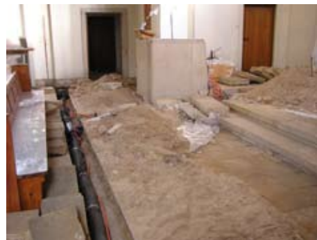
20.10.2004 Heizschläuche und Elektrokabel sind in einem Graben verlegt
