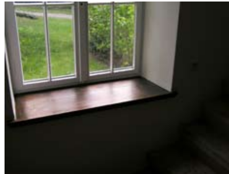
17.08.2005 Fenster im Kirchenvorraum nach der Sanierung
