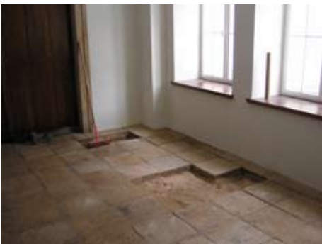
16.03.2006 Sanierung der Sandsteinplatten im Kirchenvorraum
