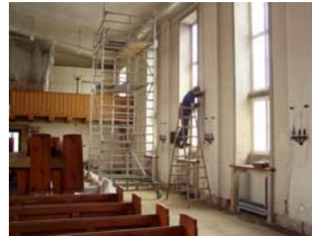
19.11.2004 neue Lautsprecherkabel und Anschlüsse werden unter Putz verlegt
