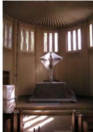
20.06.2005 erste Schutzmaßnahmen zu Beginn des 2. Bauabschnittes
