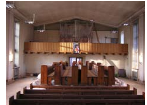
26.11.2004 Die neuen Deckenleuchten sind fertig installiert
