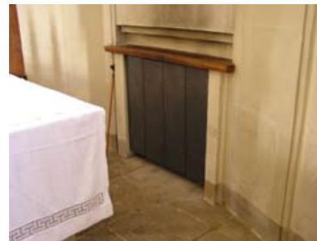
05.06.2005 Neue Heizkörperverkleidung in der Apsis hinter dem Altar.
