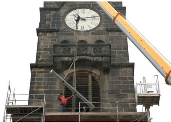
Metallteile – alle Gewerke mussten jetzt zusammenwirken. Und Gott sei Dank klappte auch alles: Der über 100 Jahre alte Balken quer durch den Turm hielt dank der zusätzlichen Versteifungen die kleine und die mittlere Glocke, so dass die Klöppel ausgebaut werden konnten und die Lagerzapfen mit einer eigens entwickelten Abziehvorrich-
