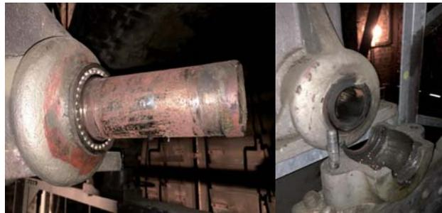
tung aus den Jochen der Glocken gezogen werden konnten. Als diese Operation auch an der großen Glocke gelang, nachdem sie hydraulisch angehoben worden war, waren wirklich alle erleichtert. Danach wurden die exakt maßgefertigten neuen Lagerbolzen eingebaut, die Lager gewechselt, alles wieder montiert und justiert. Jetzt gibt es hoffentlich wieder für 100 Jahre den tiefen Wohlklang des Bochumer Stahlgeläutes vom Versöhnungskirchturm.
