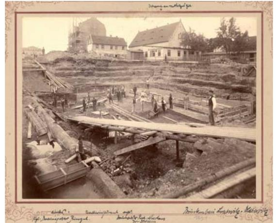
Baugrube für den Bau der Ankerkammer für die Loschwitzter Brücke, Blasewitz 1891. © Landesamt für Denkmalpflege Sachsen. Repro: Wolfgang Junius.
