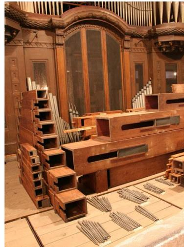
Abbau: Nach Registern und Oktaven sortierte Orgelpfeifen
