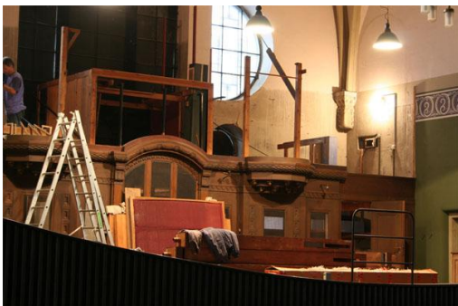
Abbau: Abbau der Windladen und Traktur
