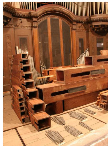
Abbau: Nach Registern und Oktaven sortierte Orgelpfeifen
