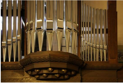
Einbau: Die ersten Prospektpfeifen stehen
