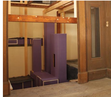
Einbau: Restaurierte Windkanäle
