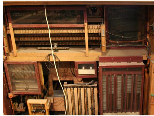
Vorgeschichte: Marode elektrische Anlage im alten Spieltisch
