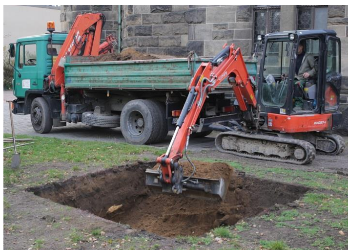
Die Pflanzgrube wird ausgehoben.
