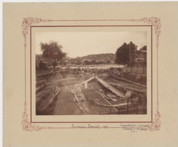
Baugrube für die Blasewitzer Ankerkammer. Aufnahme vom 7. August 1891 © Landesamt für Denkmalpflege Sachsen, Repro: Wolfgang Junius
