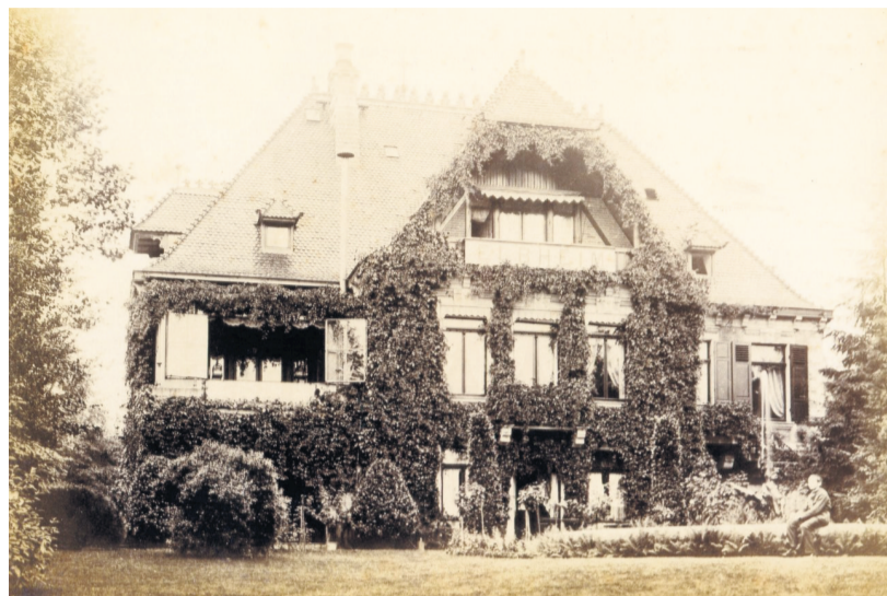
„Elbheim“ in Blasewitz, Wohnhaus von Oskar Richter, Regerstr. 1.
